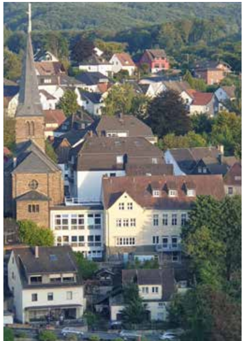
Gemeindehaus mit Anbau und Fluchttreppen 2025
