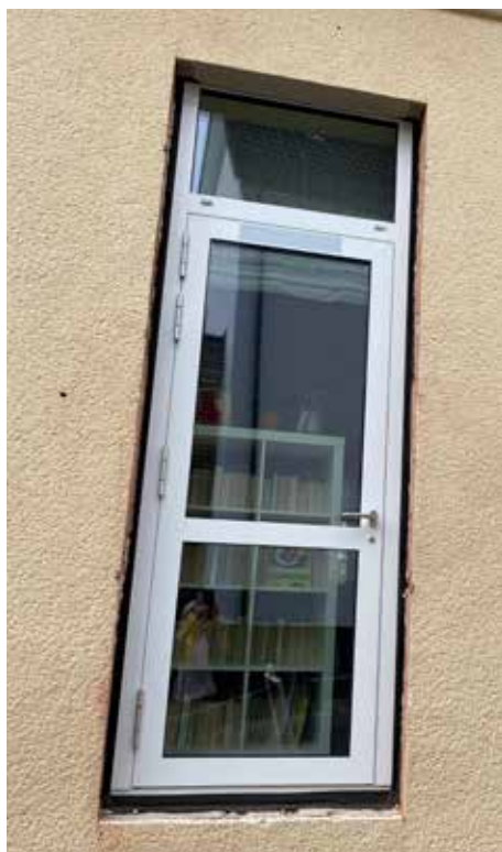
Neue Brandschutztür am großen Saal
